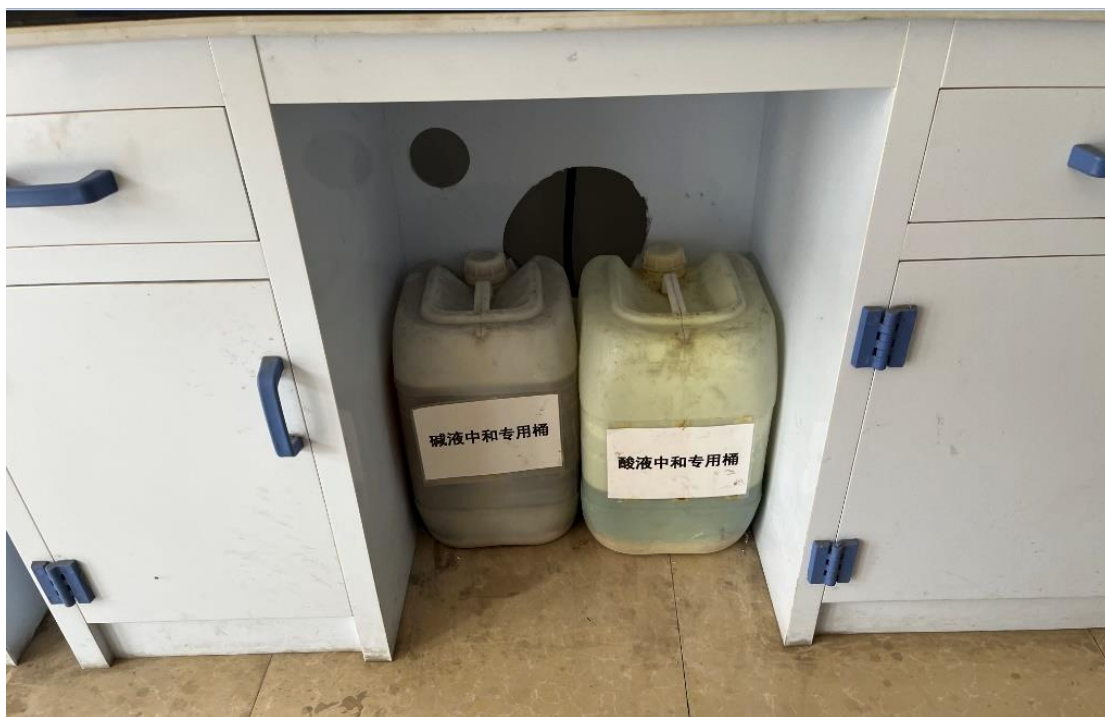
图 4.1-1 实验室废水收集设施
