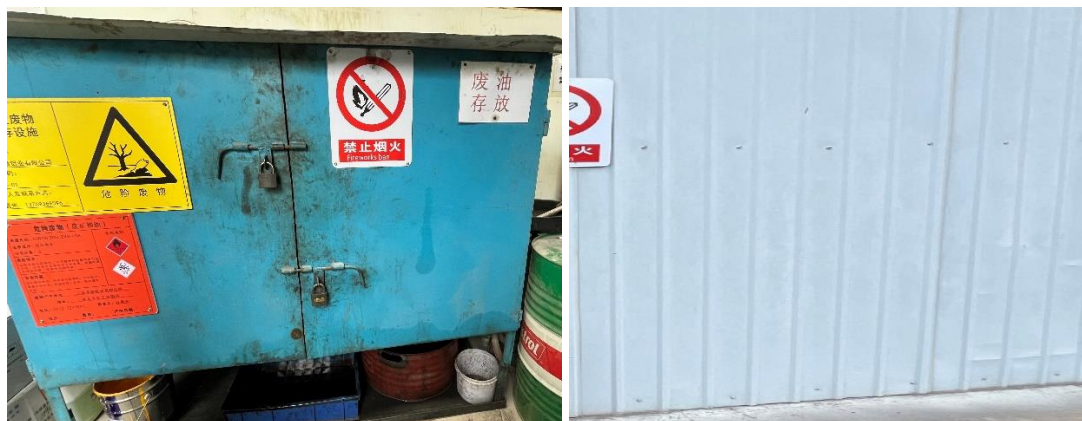
图 4.1-18 废矿物油暂存设施
